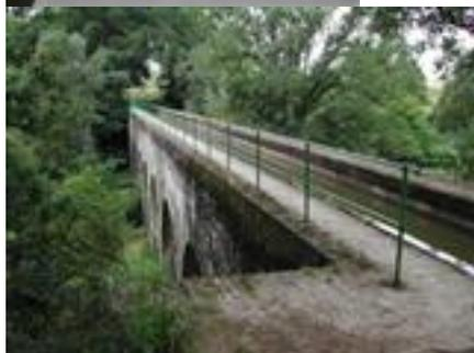
Véritable ouvrage d'art, franchie par de nombreux petits ponts de pierre, la rigole principale fait l'objet d'un entretien régulier afin d'assurer son étanchéité (à base d'argile) mais aussi de travaux de fauchage et de débroussaillage permettant aux randonneurs de découvrir un sentier ombragé par de magnifiques arbres.
